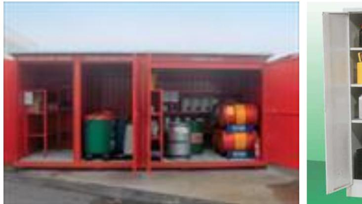
Plinske boce (acetilen i kisik u bocama za autogeno zavarivanje), boce butan-propana moraju se čuvati u tipskim atestiranim nadstrešnicama, i moraju biti osigurane od prevrtanja.
