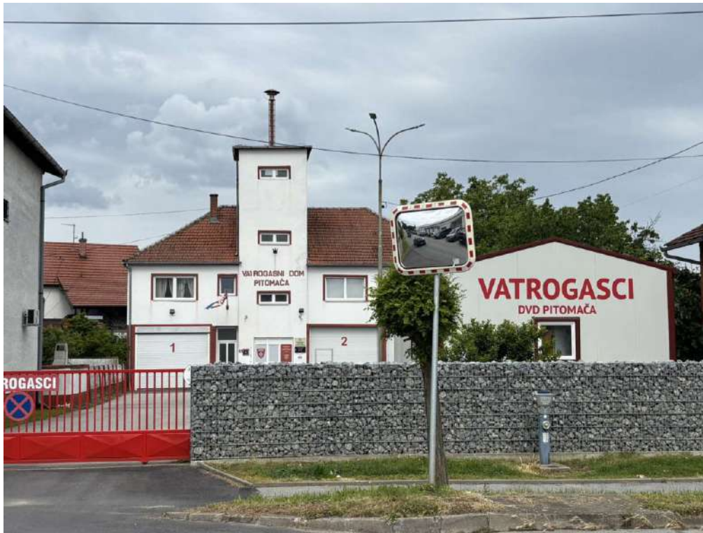
Slika 50. Prikaz zgrade DVD Pitomača
